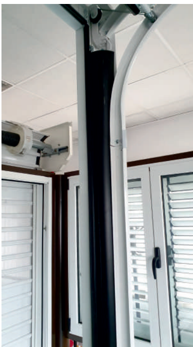
DETALLE DE PUERTA SECCIONAL DE MUELLES LATERALES.
