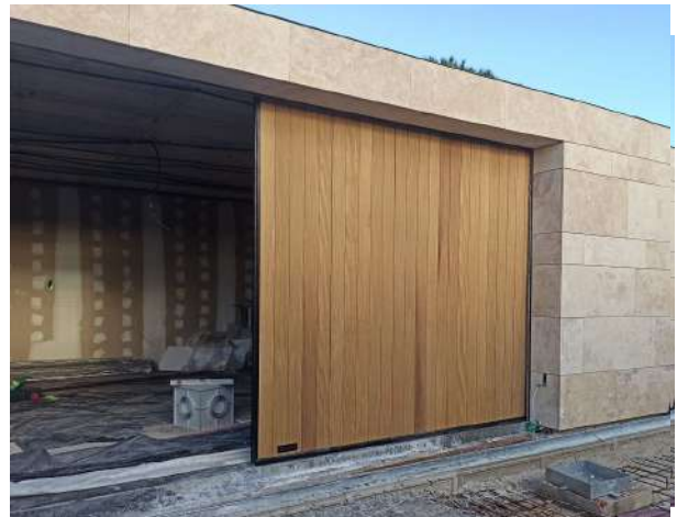
SIN GUIA INFERIOR CON PATINES 6 DESLIZADORES
