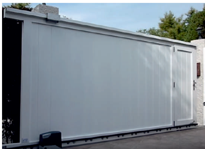
PUERTA CORREDERA (INTERIOR ) AUTOMATIZADA MEDIANTE MOTOR CON CREMALLERA NYLON.
