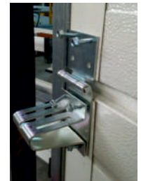
PUENTE CON BISAGRA LATERAL, EJE Y TORNILLERIA
