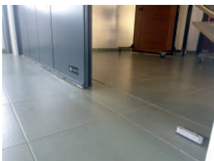
SIN GUIA INFERIOR CON PATINES 6 DESLIZADORES
