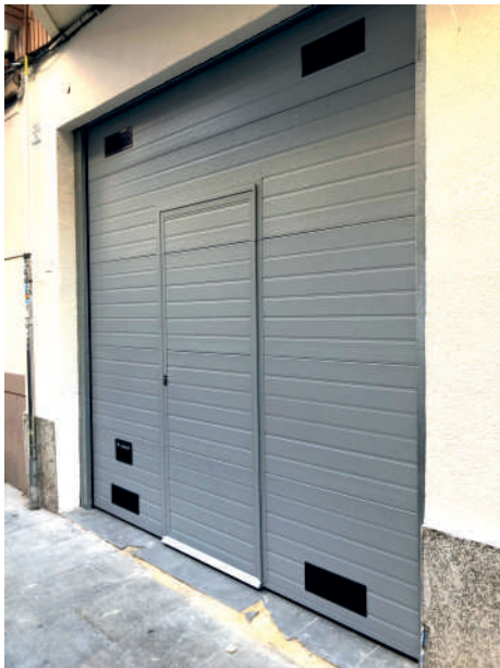
PUERTA SECCIONAL ACABADO PANEL ACANALADO HORIZONTAL GOFRADO LACADO R.A.L GRIS, REJILLAS VENTILACIÓN Y PORTÓN PEATONAL INSCRITO
