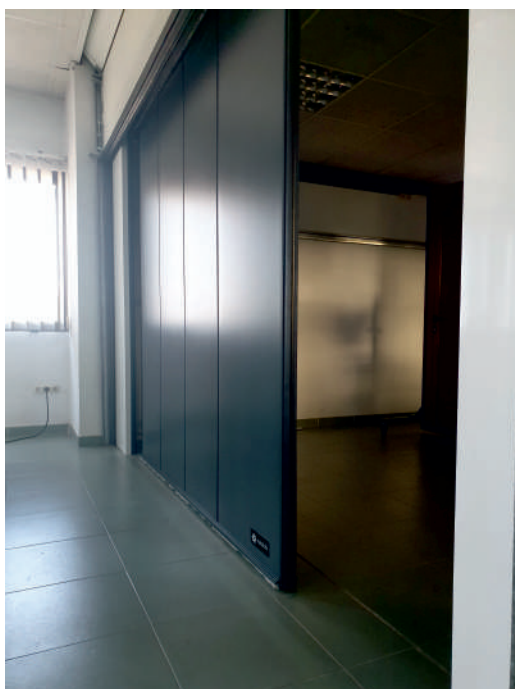
PUERTA SECCIONAL APERTURA LATERAL ACABADO DE PANEL, POSICION VERTICAL, CARA EXTERIOR LISO SIN CANAL LACADO R.A.L 7016
