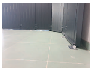
SIN GUIA INFERIOR CON PATINES 6 DESLIZADORES
